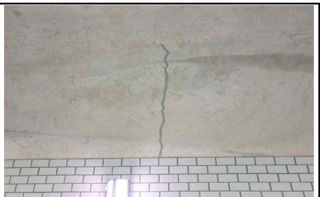
균열 보수 전경
