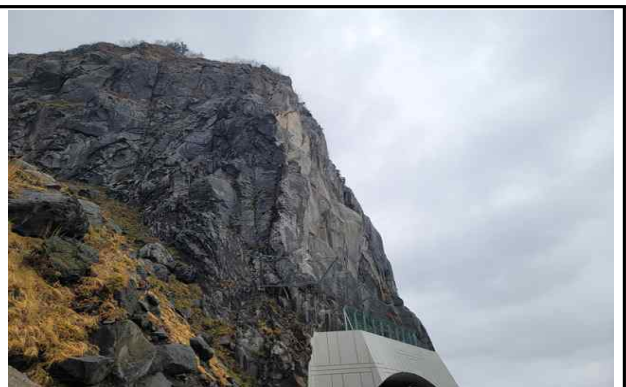
종점측 터널부사면 전경
