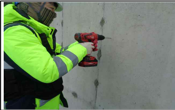
탄산화 진행깊이 시험
