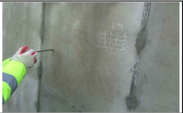
탄산화 진행깊이 시험
