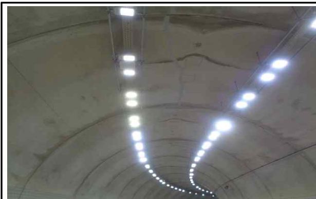
천단부 라이닝 전경
