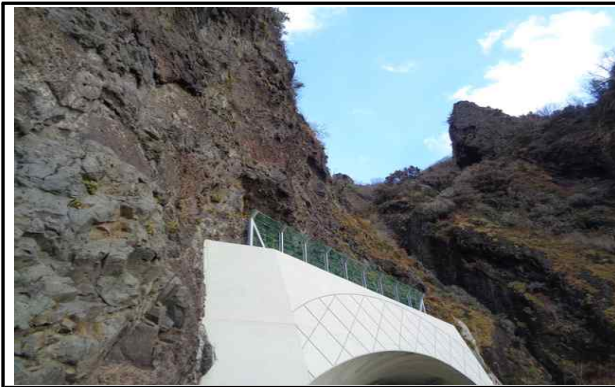
시점측 터널부사면 전경
