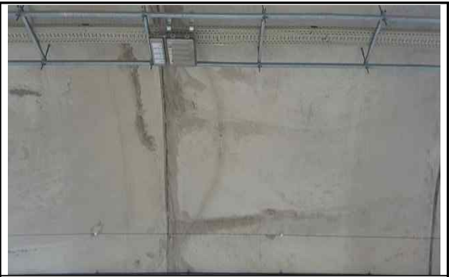
균열 보수 전경
